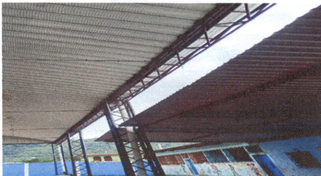
Foto 1: Sustrucción de canal de metal cancha polideportiva.
