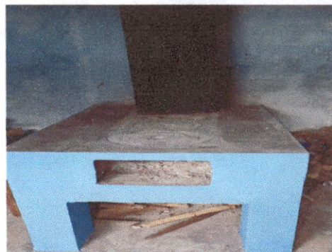
Foto 2: Sustrucción de plancha de metal de tres ornillas, mantenimiento estufa rural.
