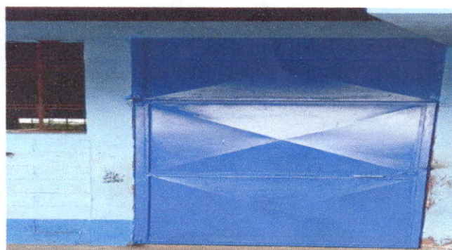
Foto 4: Mantenimiento a estructura, lijado, sepillado, sujeciones y cambio de pintura.
