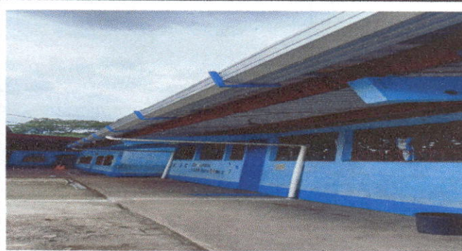
Foto 6: Sustrucción de canal de metal modulo No. 1
